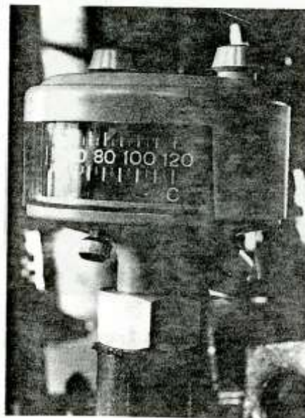
شکل (۷-۱) رله کنترل درجه حرارت سیم پیچ ها
