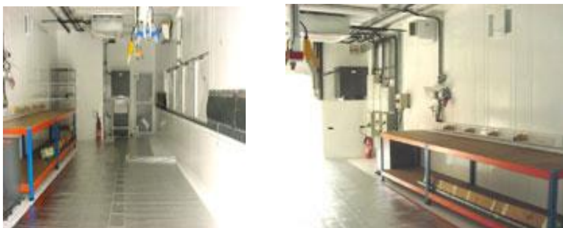
شکل ۱۴-۵: اتاق هایی برای مفصل زنی کابل ها و اتصال صحیح کابل ، تست عایقی کابل
