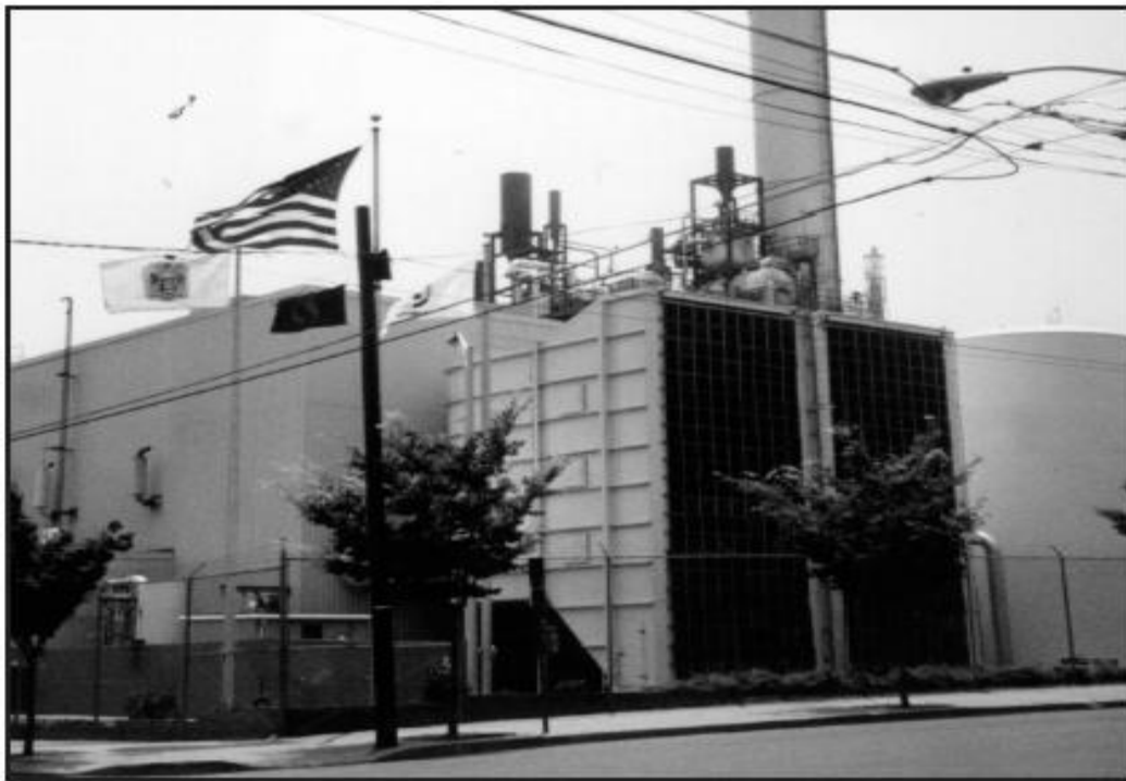
شکل ۵ - اتاق فیلتر دهانه ورودی برای Frame 7EA
