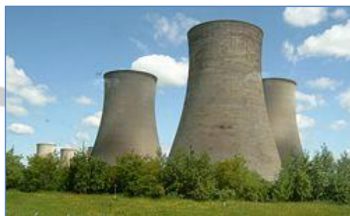
شکل ۴۴- برج خنک کننده Cooling towers
