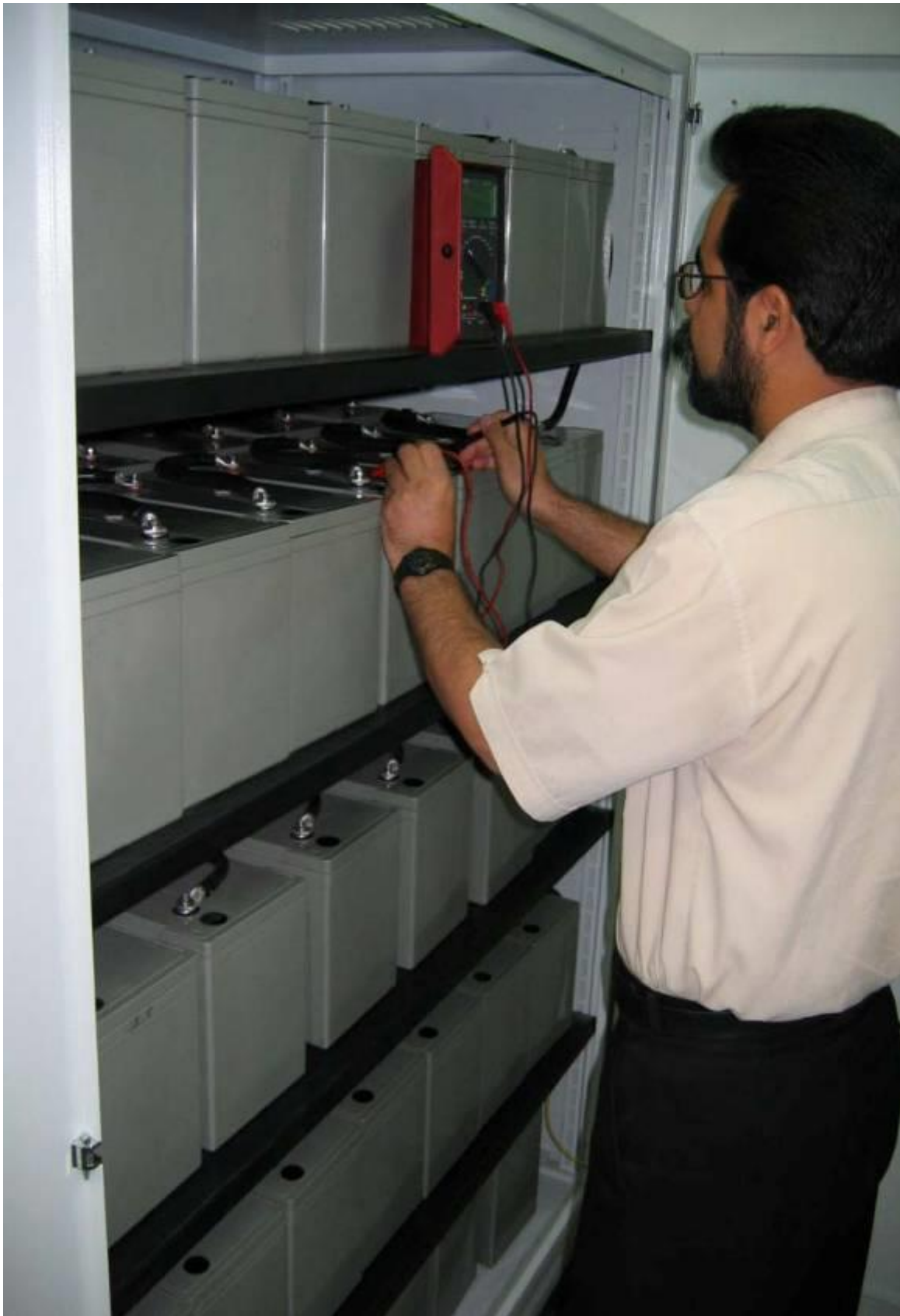
کابینت باتری UPS های IGBT
