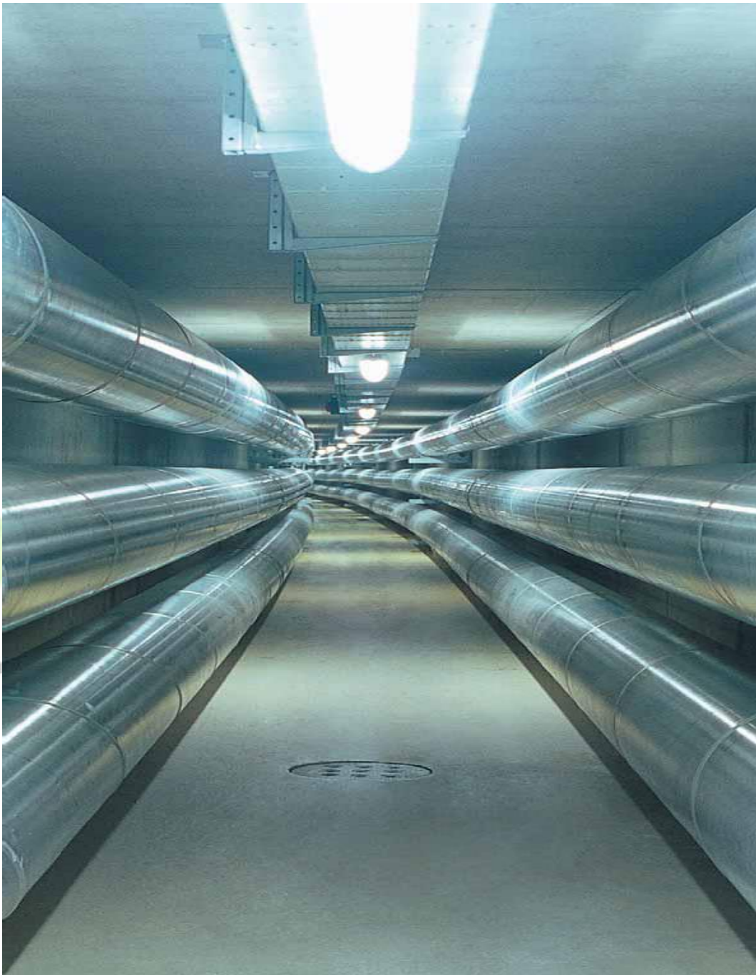
شکل ۳-۴- مدار دوتایی GIL در تونل را نشان می دهد.
