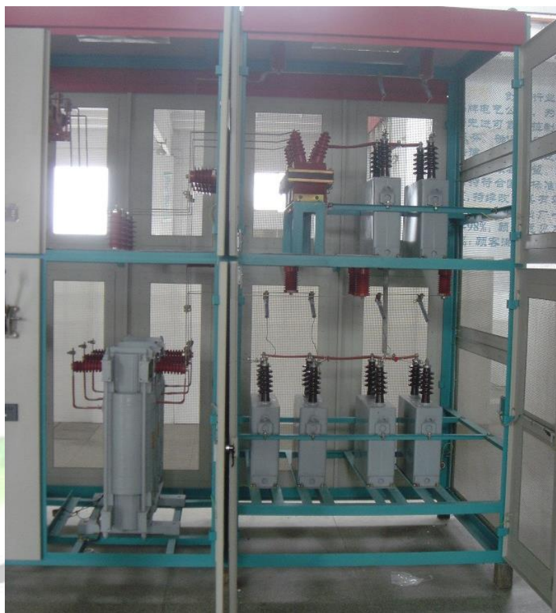
شکل ۳-۴ بانک خازنی با واحدهای خازنی دوبوشینگی
