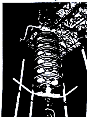
شکل ۸-۱۱. نمای ظاهری بشقابها و زنجیر مفره مجهز به المان واریستور.
