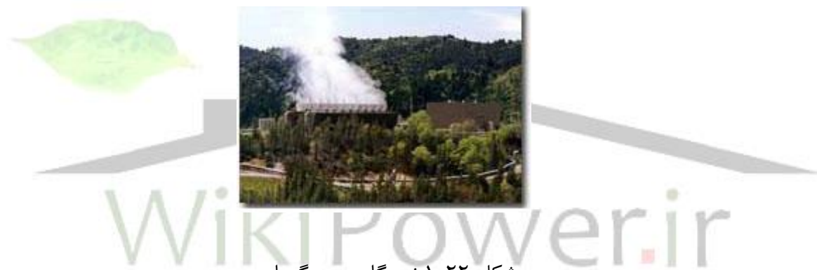
شکل ۲۲-۱ نیروگاه زمین گرمایی
