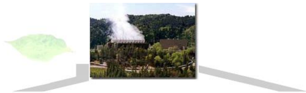
شکل ۲۲- نیروگاه زمین گرمایی
