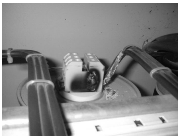
شکل Error! No text of specified style in document. ۹- کنتاکت خازنی آسیب دیده
