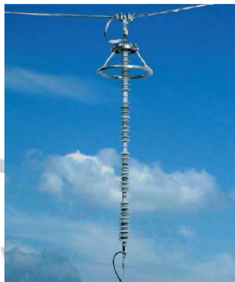
شکل ۸-۱۱: یک نمونه برقگیر TLA
