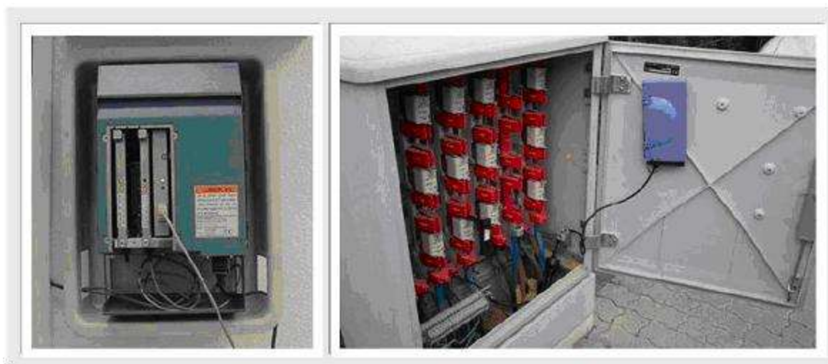
شکل (۱-۱۷): نمونه‌ای از دو تکرار کننده در اتاق کنتور و کابینت خیابان ۳۸
