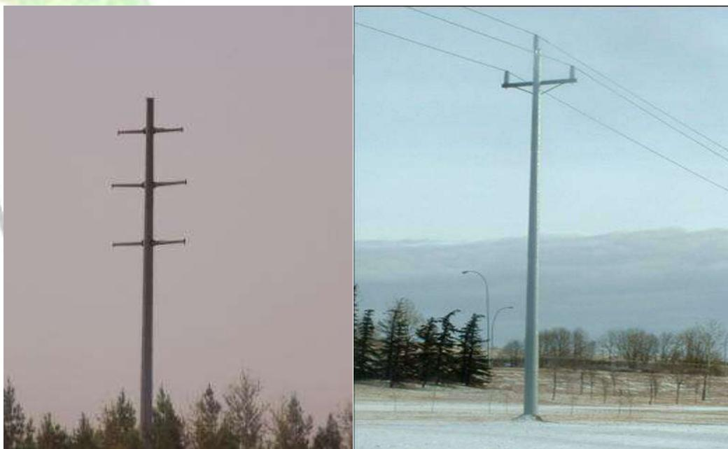
شکل ۱-۶- استفاده از تیرهای حمل کابل کامپوزیتی
