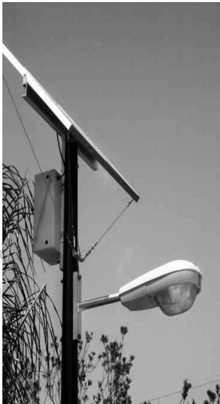
شکل ۲-۶- نمونه ای از تیرهای کامپوزیتی در روشنایی معابر
